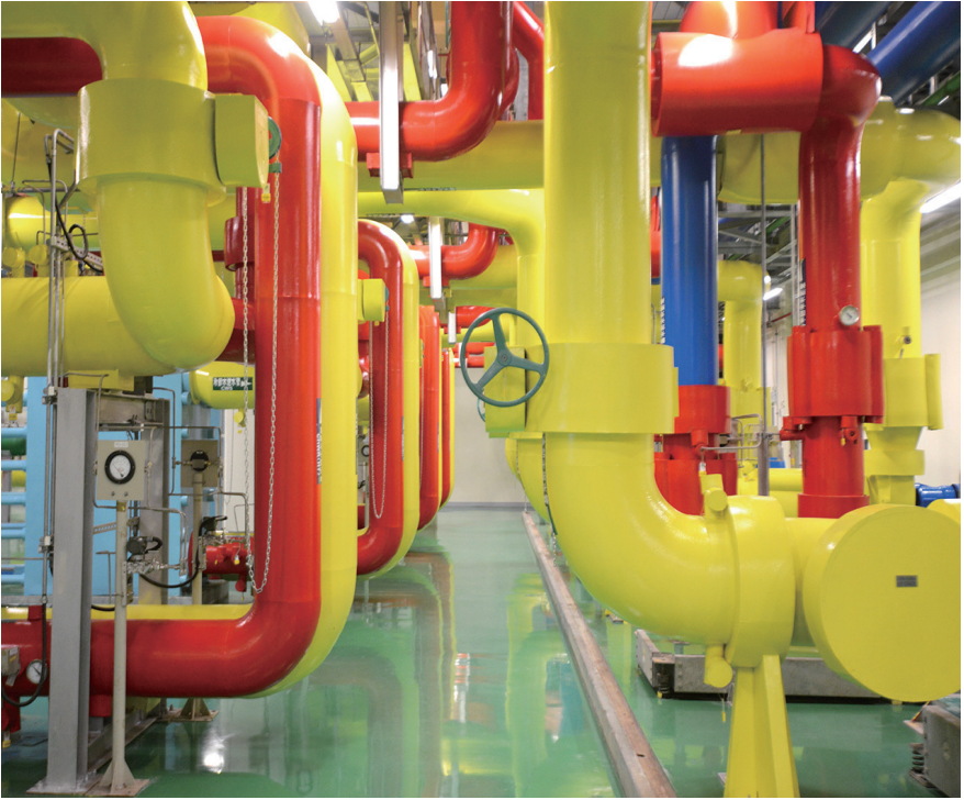
▲ Google台灣資料中心能夠達到PUE=1.12，在於大量採用於冷水管散熱，並且利用晚上冷空氣將熱水降到最低溫，所以自然可減少電力使用。 Google
