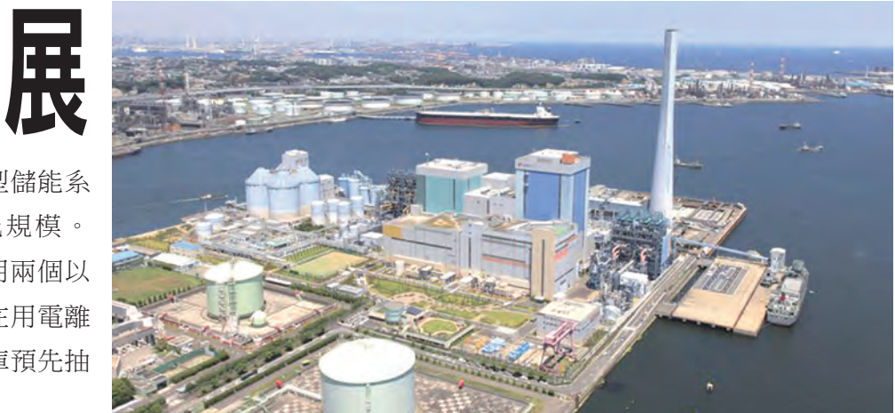
2009年J-POWER磯子火力發電廠改用USC燃煤設備後，發電效率大幅提升至45%。在防止汙染物產生部分，可減少95%硫氧化物、87.5%氮氧化物排放，以及減少99.9%煤粉塵。
